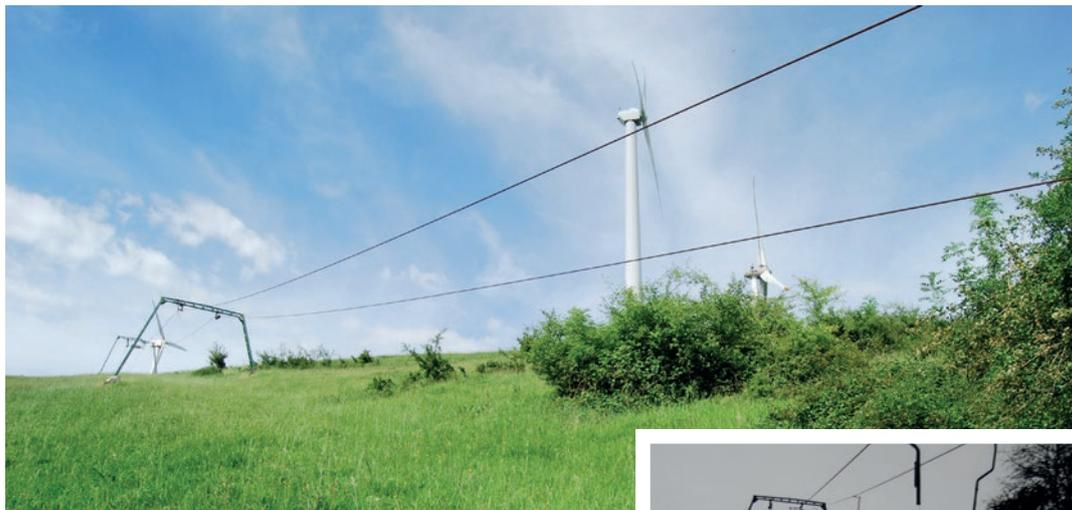
leistung, da die 70.000 Mark für einen kompletten Lift nicht aufzubringen waren. Am Ende hatte man einen 260 Meter langen, Doppelanker-Schleplift, welcher circa 20 Personen gleichzeitig befördern konnte. Für den Antrieb sorgte ein 40 PS-Dieselmotor aus einem alten Daimler-Benz. An manchen Tagen tummelten sich bis zu 200 Skisportbegeisterte am Hang.
